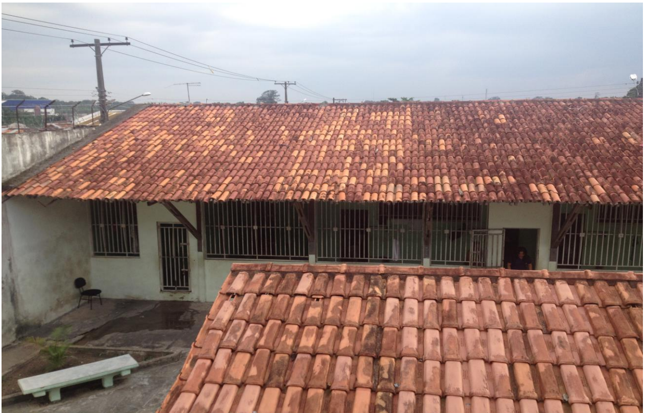
Figura 13. Vista dos alojamentos: perspectiva da sala do atendimento técnico. Fonte: Adriana Macedo, 2013.
