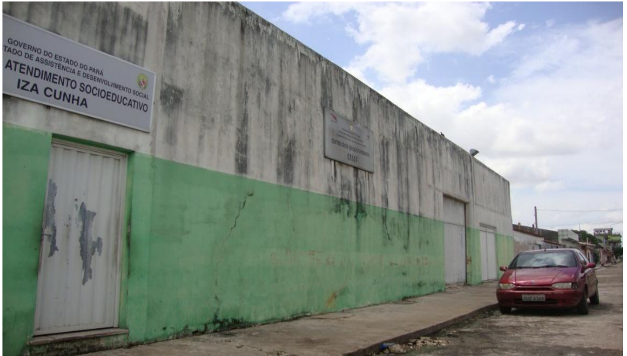
Figura 5. Imagem das entradas do CESEF/PA e placas de identificação do centro. Fonte: Adriana Macedo, 2013.
